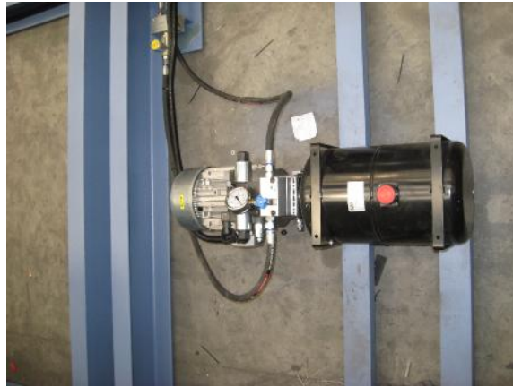
Centralina idraulica per il sollevamento
